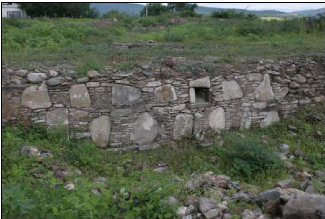
Figura 3- Muro este del basamento de una estructura al pie suroeste de la Peña de Huehuepiaxtla (la apertura de un desagüe se aprecia en ambas tomas).
