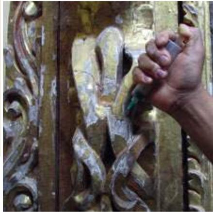
El fijado de las escamas se realizó con un pegamento conocido como cola de conejo diluido en agua y con unas gotas de esencia de clavo como conservador natural. Dicha mezcla se aplicó por inyección tras aplicarse previamente una mezcla de agua y alcohol cuya finalidad era permitir que el adhesivo se introdujera de manera uniforme y estable en el interior de cada escama y cada fisura.
